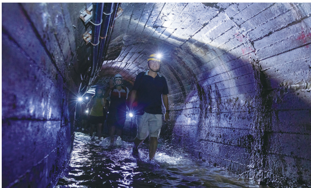
在能高大圳第四號隧道裡，大家踏水前進
