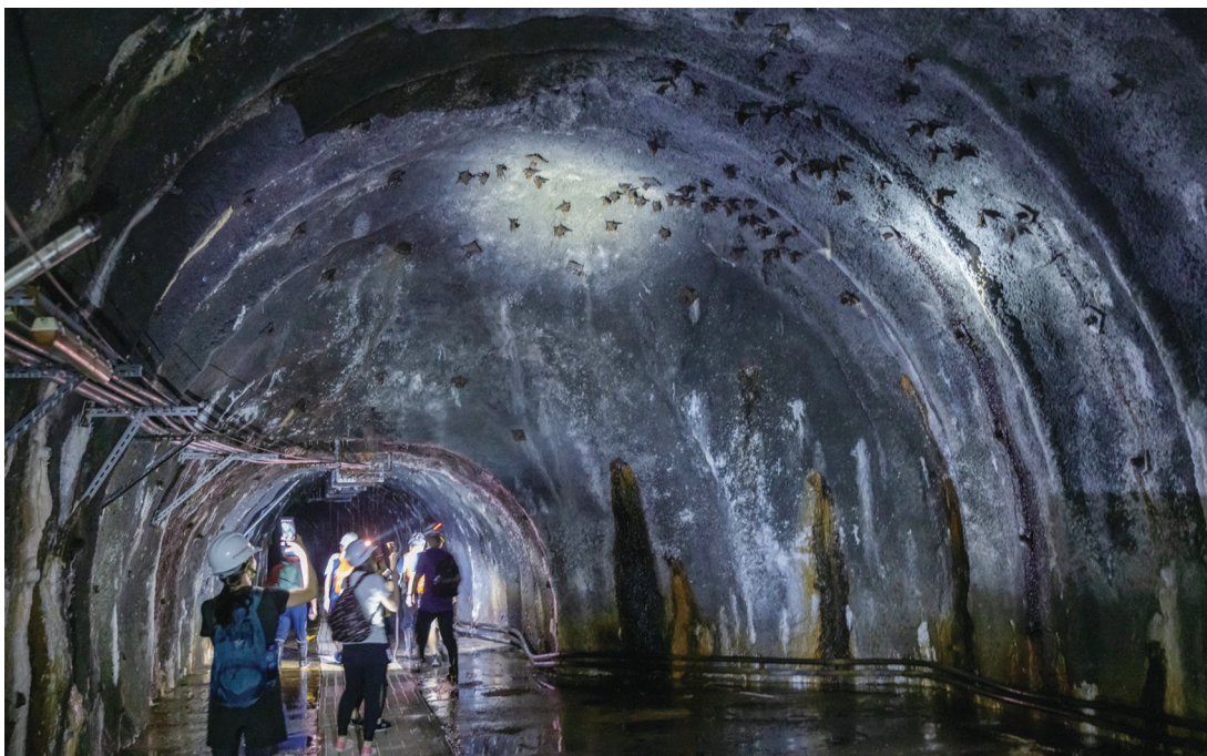
民國96年完工的新式雙層隧道，隧道上方為維修車道，下方才是輸水渠道，寬敞的隧道空間成為蝙蝠棲息的場所
