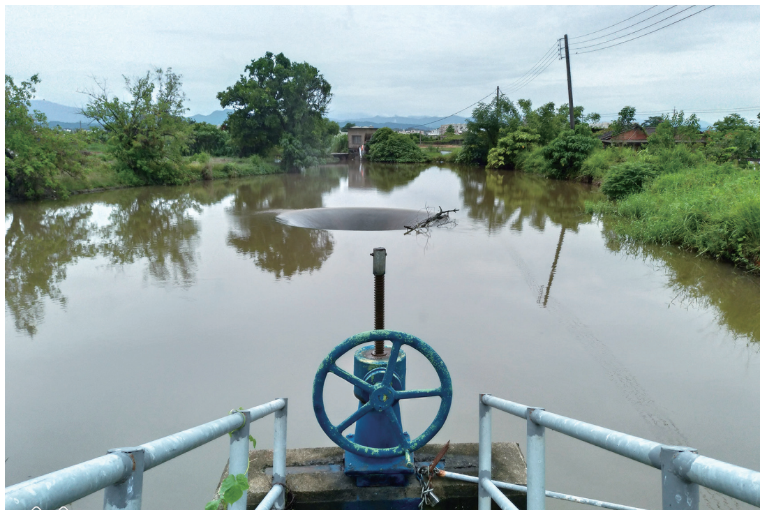
瓦礫埤放水設施(豎坑、放水門)
