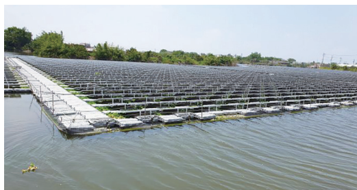
水面型太陽能光電系統內水生植物
