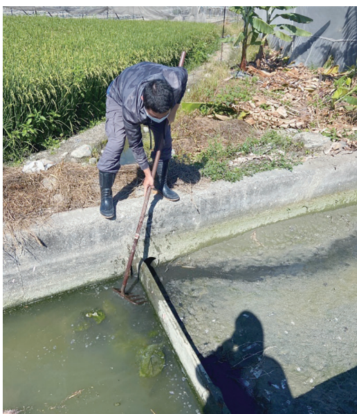
圖4、本處同仁加強巡邏排除未依規定之私人取水設施
