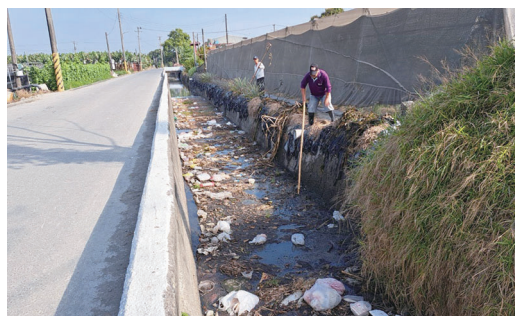
圖2、渠道巡視及清理
