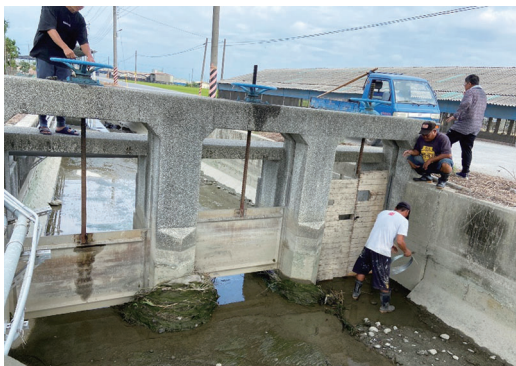
圖5、緊急僱工維修萬丹圳第1制水門
