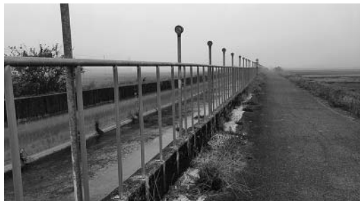
支分線臨路設置欄杆
