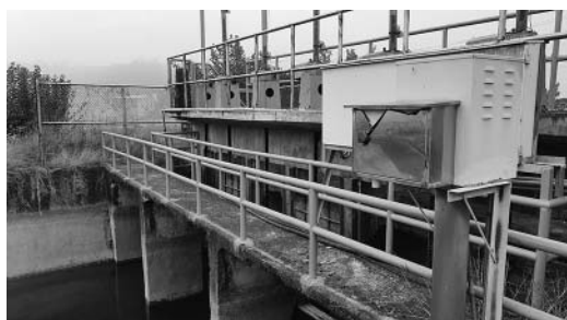
操作平台設置欄杆
