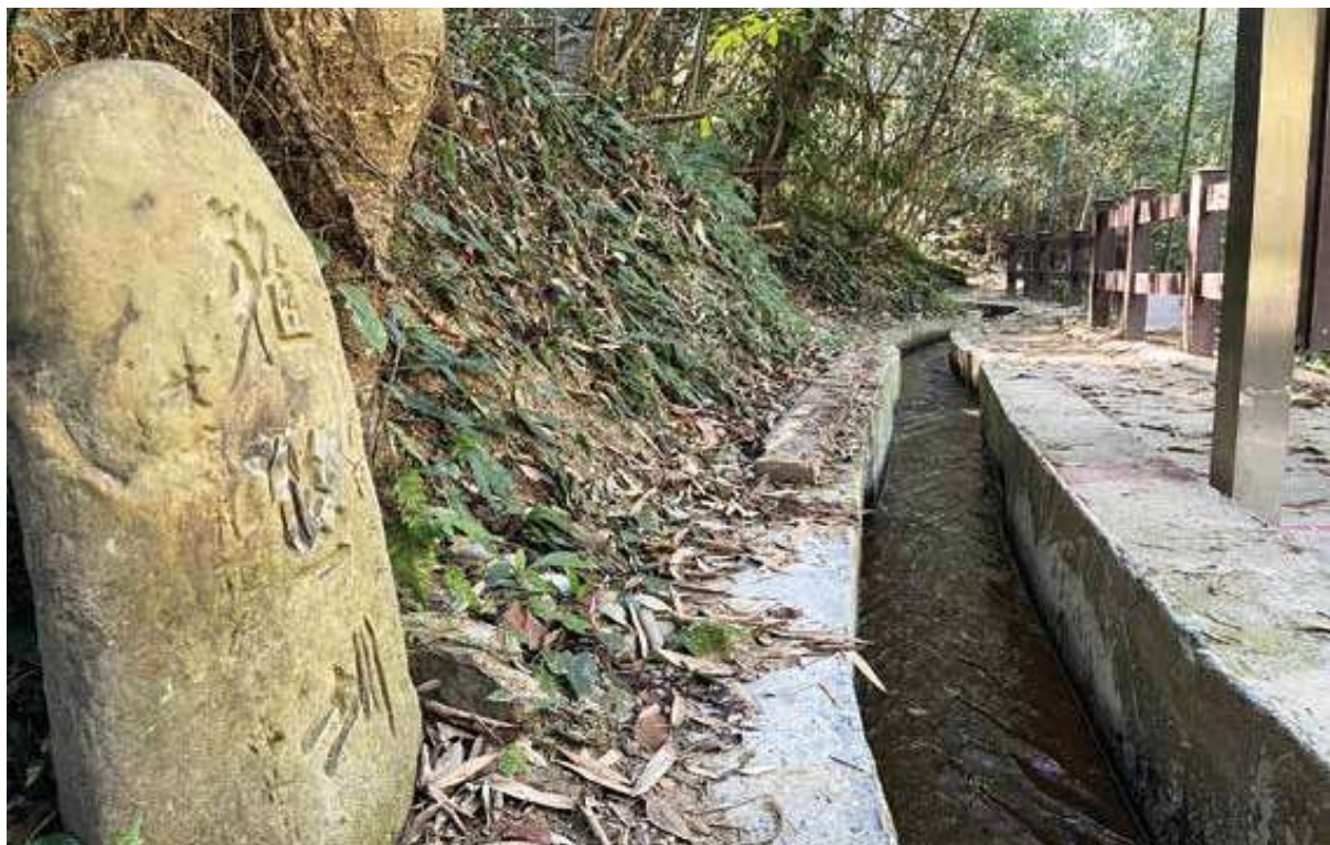
大湖鄉雅悠圳路改善工程竣工現況
