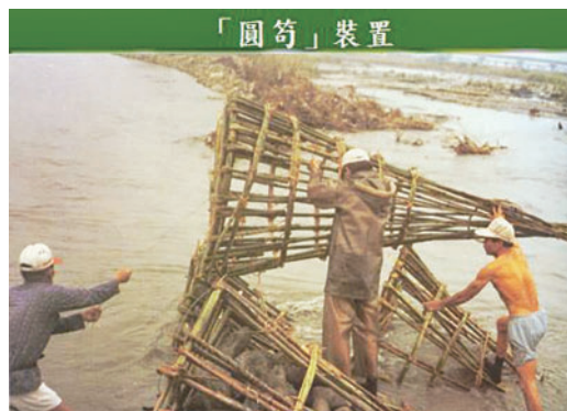
「林先生」傳授之導水工法－石筍（資料來源：農水署彰化管理處）
