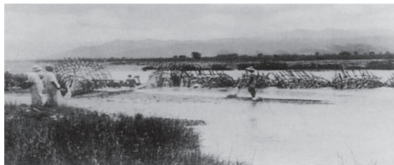
「林先生」傳授之導水工法－石筍（資料來源：農水署彰化管理處）
