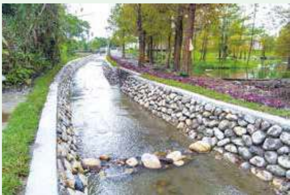
水源地排水水源四中排(第一期)渠道改善工程
