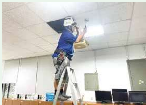
安裝差動探測器
