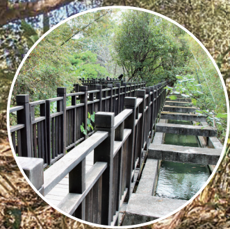
水圳建造在高高的橋上，水在橋裡面流(攝影：李建志)
