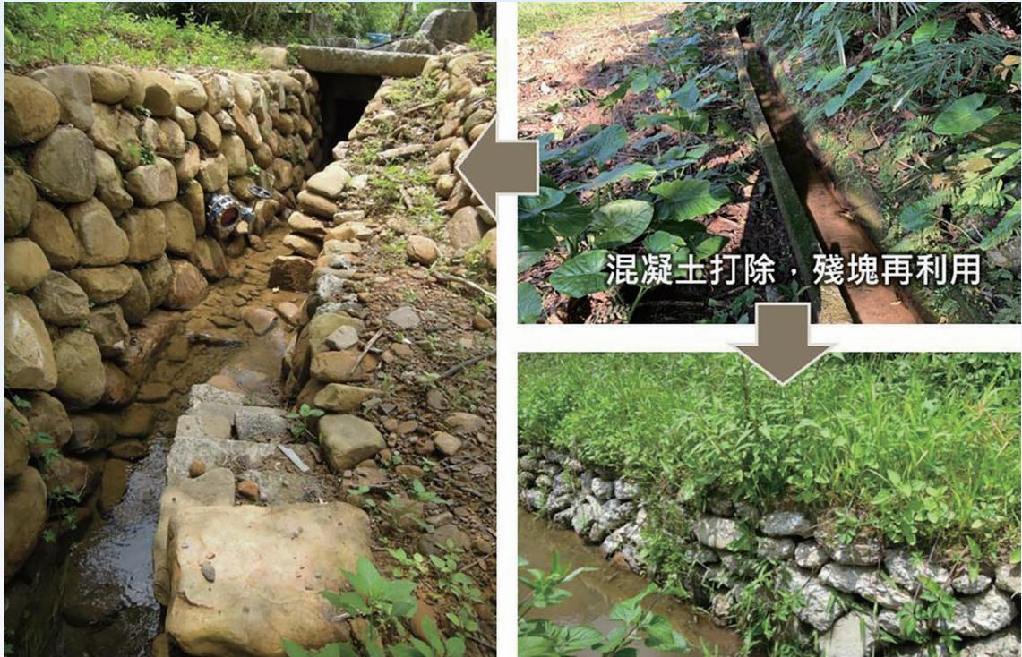
圖1 混凝土水圳打除殘塊再利用之襯砌生態水圳
