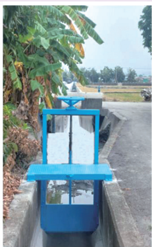
閘門操作平台
