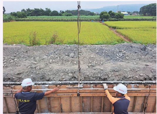
木作系統模板吊裝組立
