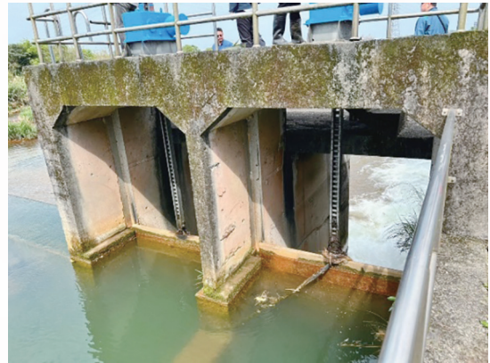
圖4 雲林管理處-北港支線二區終點放水門
