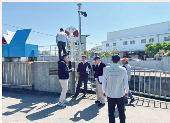
圖6 七星管理處-雙溪橡皮壩現地抽檢
