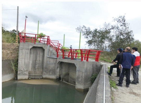
圖8 臺東管理處-林田圳排水閘門現地抽檢
