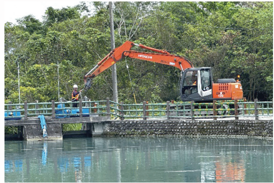
圖17 大型機具開啟排水閘門
