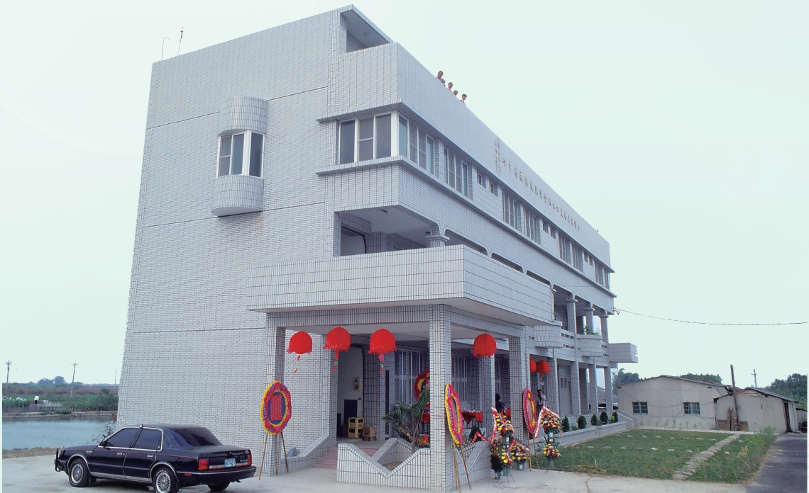
試驗站重建，於1990年9月完工，更名為灌溉技術推廣中心
