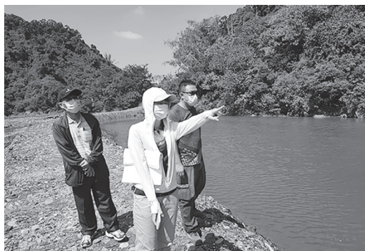
農水署柯雅卿蒞處查驗泰山圳進水口搶修工程
