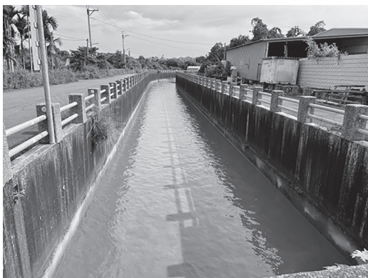
預計設置太陽能光電發電設備基地現況
