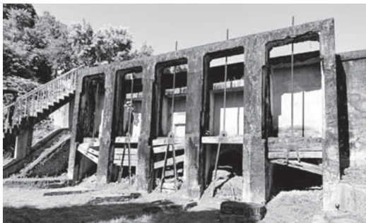
曹公圳五孔涵進水門
