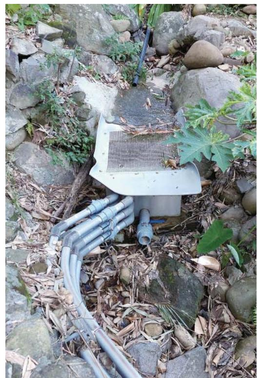
新研發的取配水箱可以過濾落葉，以免造成水管阻塞
