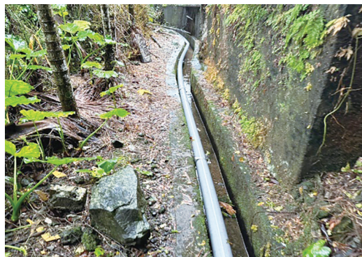
廣興圳灌溉區域管線佈設工程
