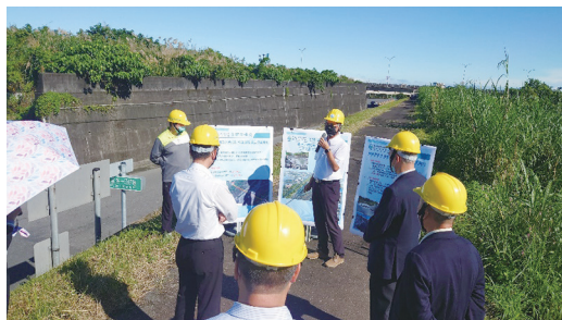
蔡昇甫署長蒞處督導埔林圳倒虹吸工災害搶修工程
