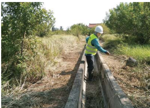
現地掌水人員清除水路垃圾雜物
