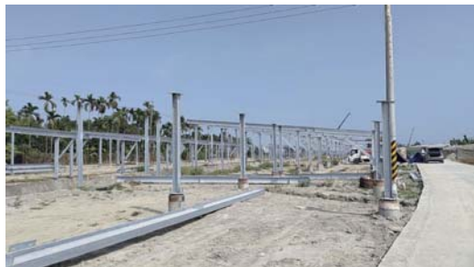
屏東管理處目前正在施工中光電案場
