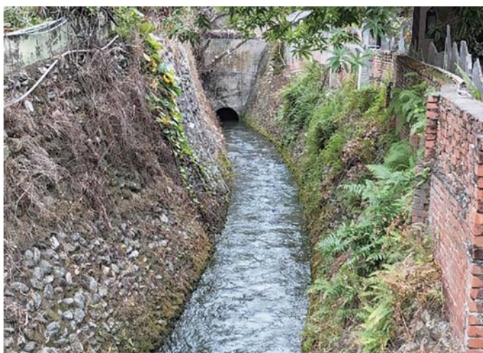
圖1 泰山圳竣工紀念碑及其周邊圳路現況
