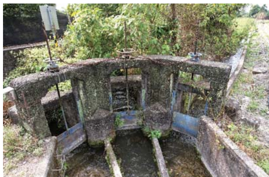
圖3 泰山圳分水工現況(左圖下游側、右圖上游側)
