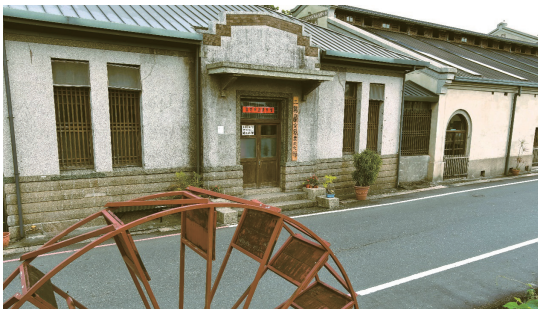
二結穀倉是五結鄉歷史最悠久的農產專業倉庫（縣定古蹟）
