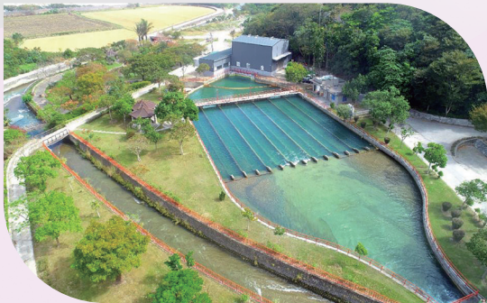
臺東管理處關山圳沉砂池小水力電廠(設置容量1,000kW)
