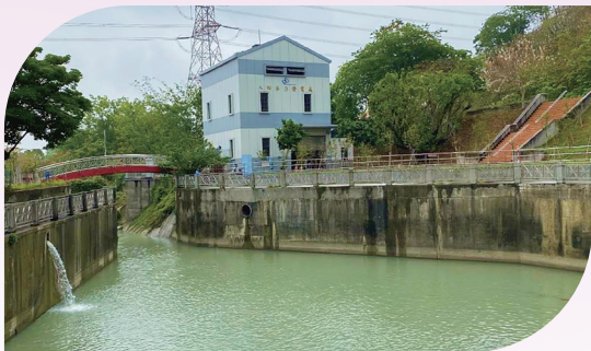
嘉南管理處八田電廠小水力電廠(設置容量2,196kW)
