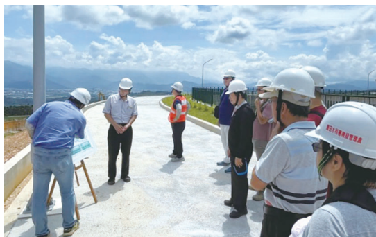
北基管理處參訪大坪頂調蓄池現場簡介
