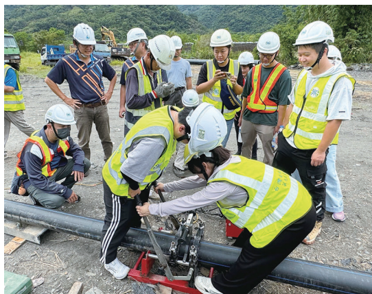
參訪人員親自體驗HDPE管接管過程
