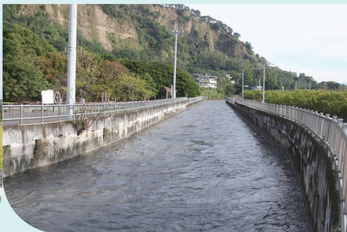
濁水溪水源透過集集攔河堰北岸聯絡渠道引入八堡圳
