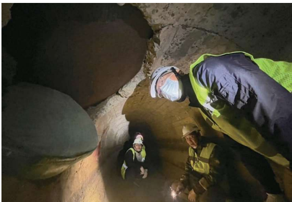
陳處長等一行人並進入隧道內檢視
