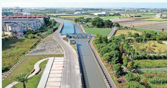
圖6 濁幹線-調節補助安慶圳調蓄池
