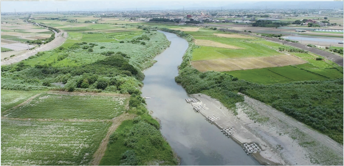
圖2 北港溪倒虹吸工現況照片
