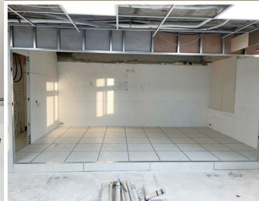
圖2、發電機系統 圖3、地板架高
