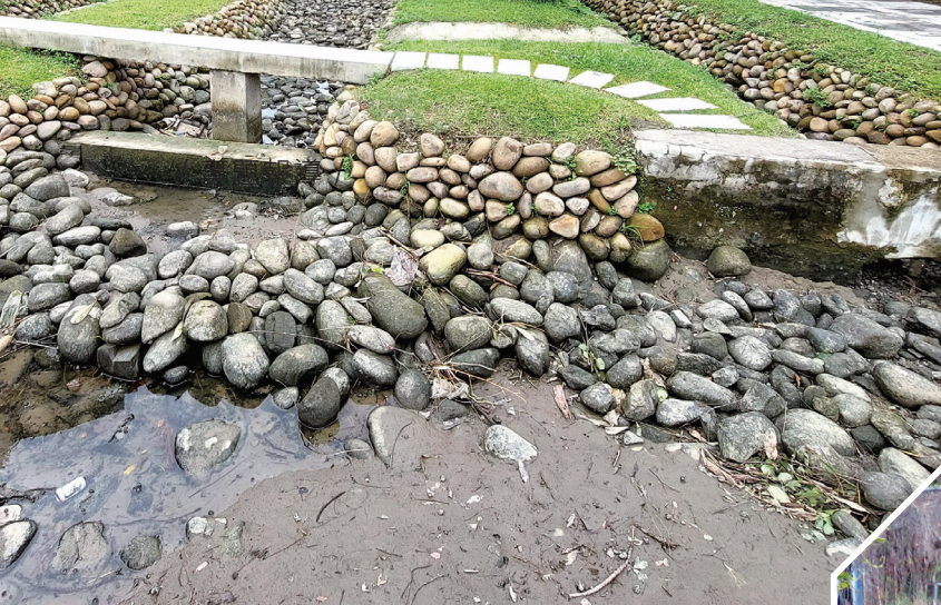
左上 圳岸以石塊取代原本光滑的清水模，為動植物創設生存空間 右上 北基灌區金泉古二圳施設生物避逃坡道 右中 沒有裝設欄的水圳旁騎自行車潛在危險性 右下 溝壁砌上大小石頭交錯產生空隙，有如魚礁可讓魚蝦窩藏，苔蘚蕨類容易生長披覆
