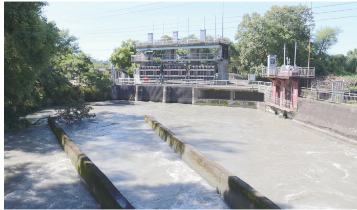
上 北岸取水口與集集攔河堰管理中心 下 濁水發電廠進水口
