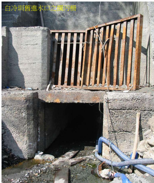
白冷圳舊進水口之攔污柵
