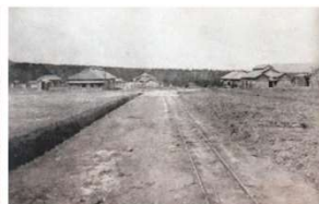
圖 2-25 大南庄第二苗圃事務所及臺車軌道
