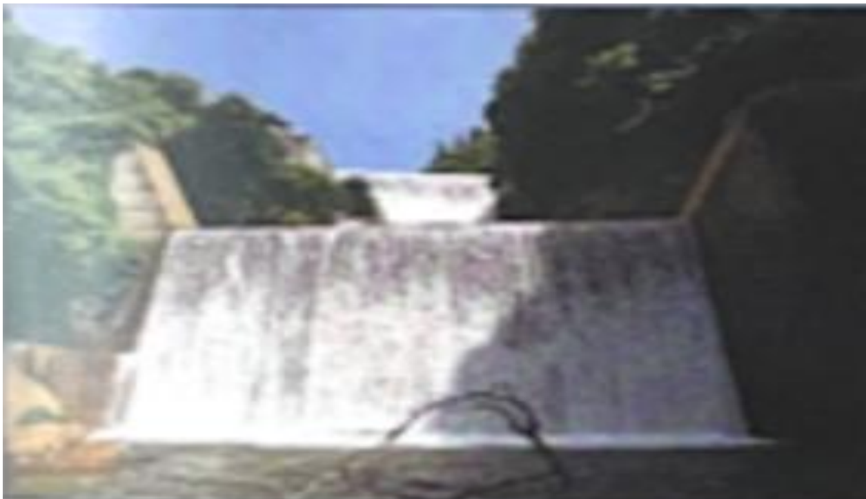
2015年 高井發電廠 420KW
